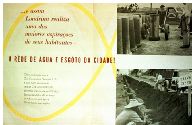
11. Primeiros anos 50, a comunidade é conclamada a financiar a construção da rede de tratamento de esgotos. Acervo Widson Schwartz
