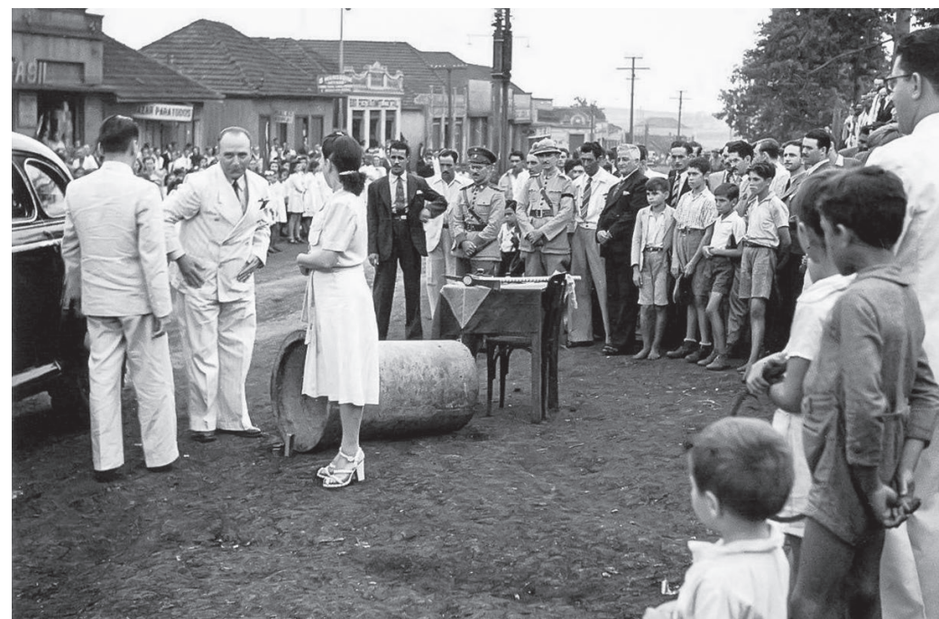
6. Início solene das obras de pavimentação, com o prefeito Miguel Balbino Blasi na Avenida Paraná. Autor Carlos Stenders/Acervo Câmara Clara
