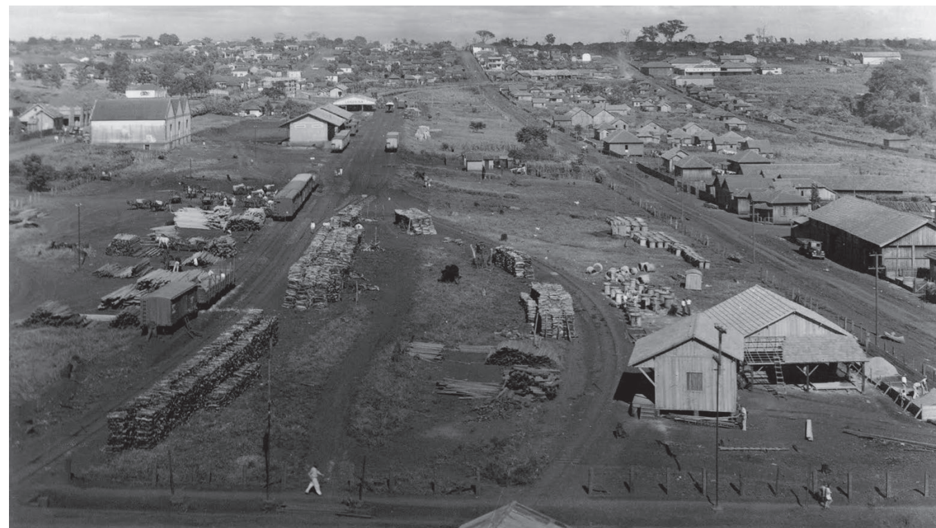
7. Pátio da Estação Ferroviária de Londrina, durante a construção em 1935. Autor Carlos Stenders/Acervo Museu Histórico de Londrina Padre Carlos Weiss-UEL
